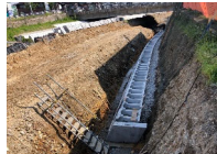
④設置完了
