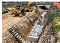
③ブロック設置
