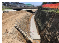
②均しコン完了
