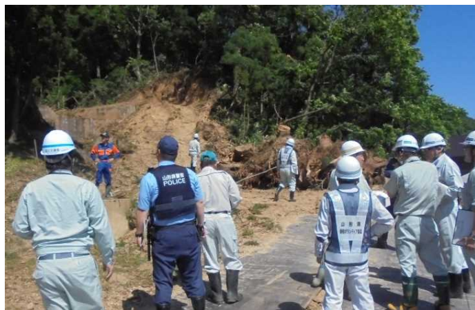
戸沢村 危険箇所点検の様子
