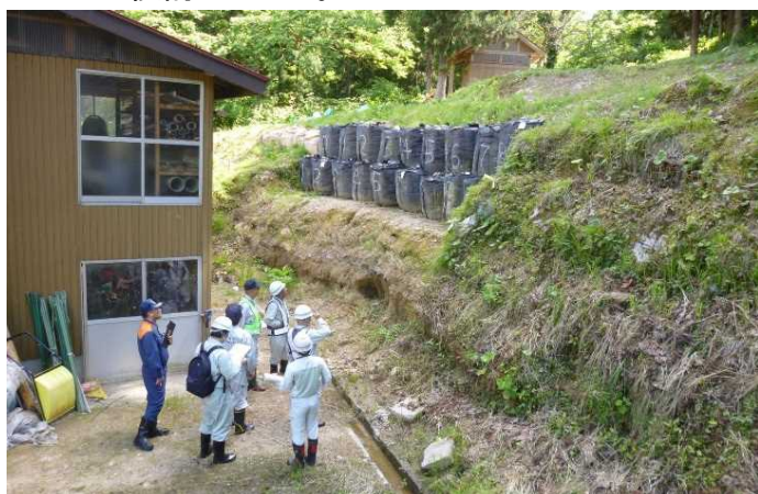
大蔵村 危険箇所点検の様子
