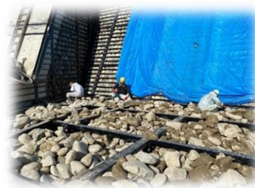
詰め石作業状況
