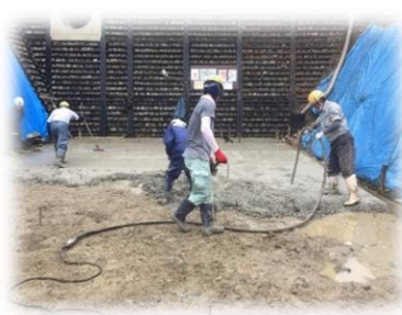
均しコンクリート打設状況
