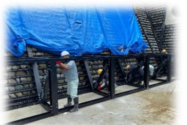
鋼製枠組立状況
