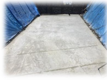
均しコンクリート打設完了
