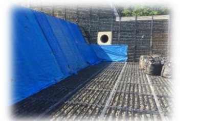
詰め石作業完了
