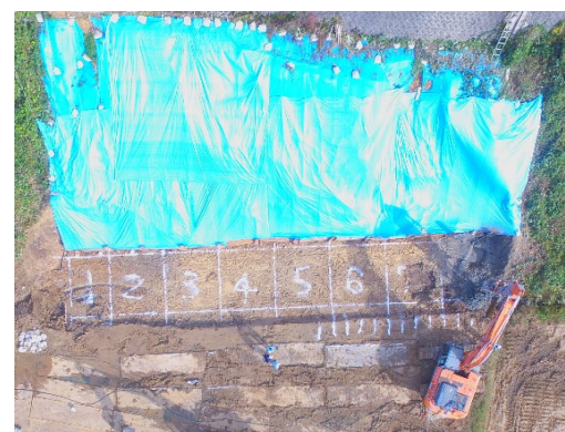
中層混合処理状況
