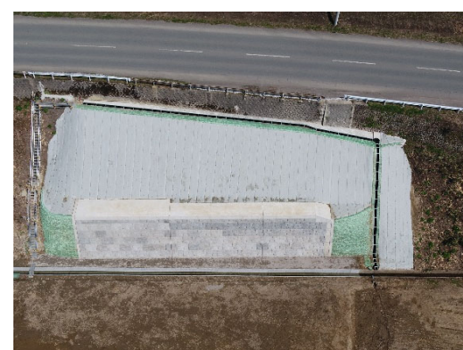
工事完了全景
