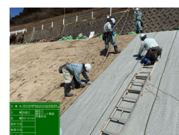
植生シート敷設
