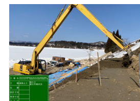
盛土材敷均し
