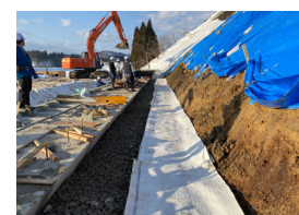
吸出防止材敷設
