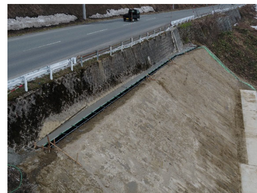
上部排水施設完了
