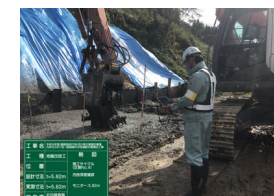
中層混合処理
