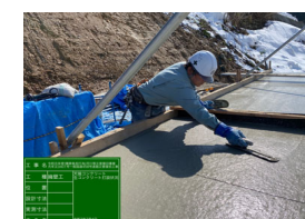
天端コン【仕上げ】
