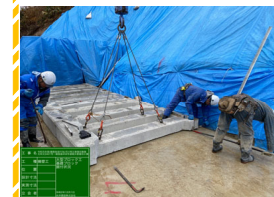
基礎ブロック据付
