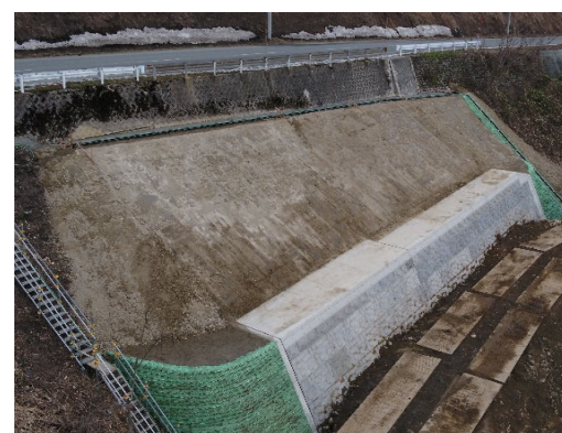
盛土工完了全景
