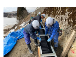
角型U字溝敷設
