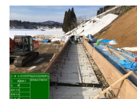
天端コン【型枠】
