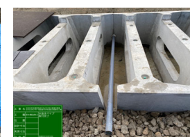
水抜きパイプ設置
