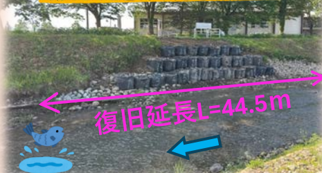
◎指首野川右岸横内橋下流 第4018号外千門町工区
